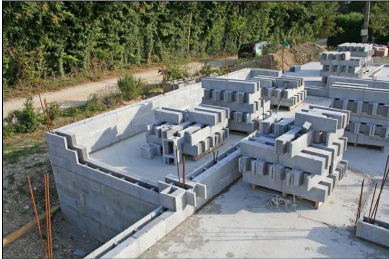
Le Vertitherm<sup>®</sup> permet de monter des murs porteurs
